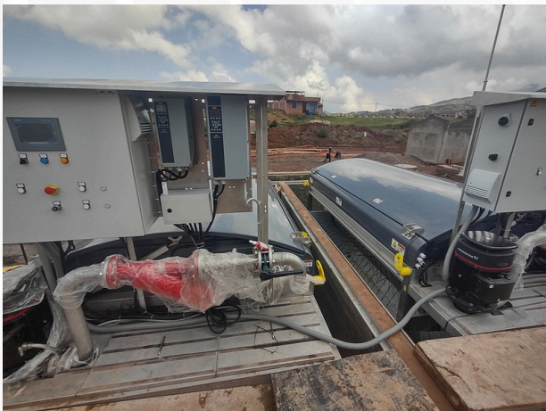
Instalación de filtros rotativos - PETART
