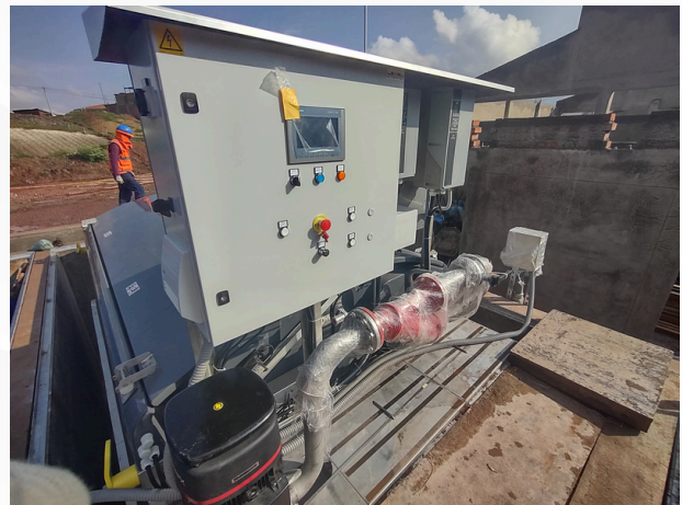
Instalación de filtros rotativos - PETART
