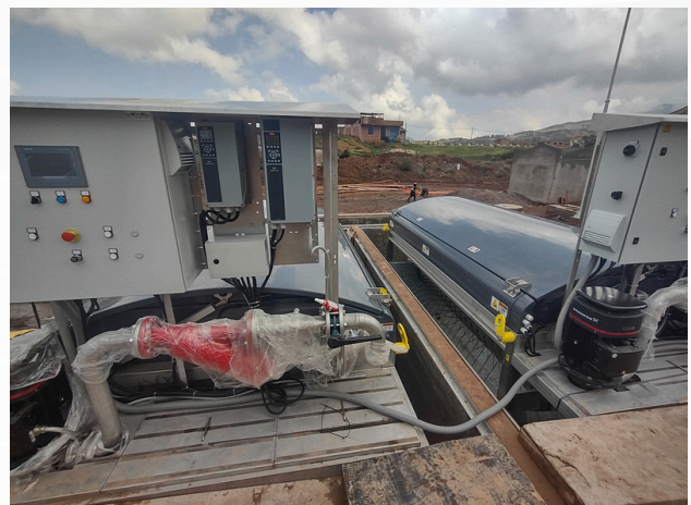
Montaje de una electrobomba split case
