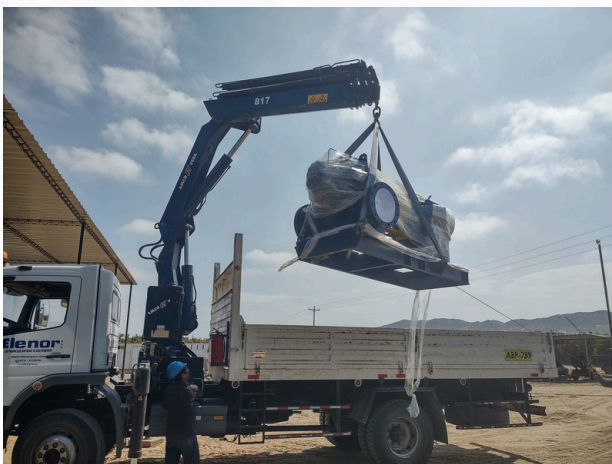
Montaje de una electrobomba split case
