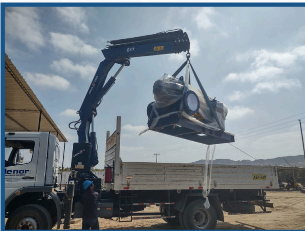
Montaje de una electrobomba split case
