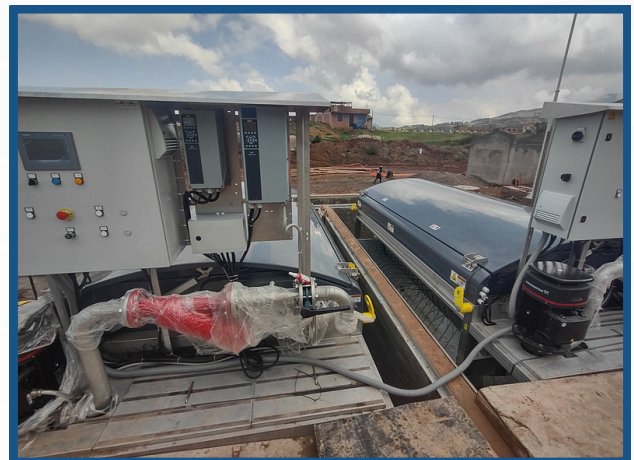
Montaje de una electrobomba split case
