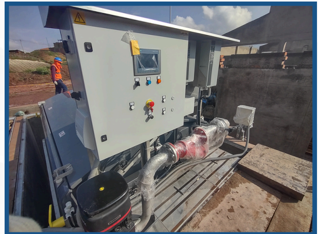
Instalación de filtros rotativos - PETART
