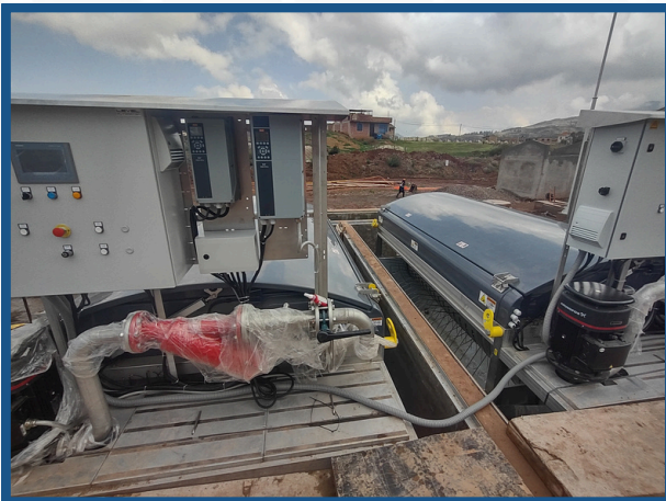
Instalación de filtros rotativos - PETART
