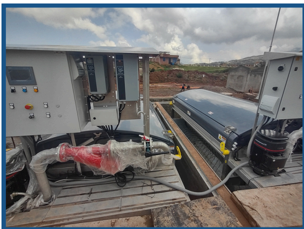
Instalación de filtros rotativos - PETART
