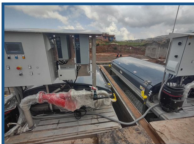
Montaje de una electrobomba split case
