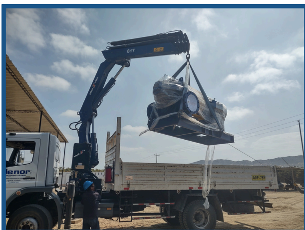
Montaje de una electrobomba split case
