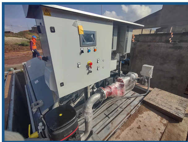
Instalación de filtros rotativos - PETART
